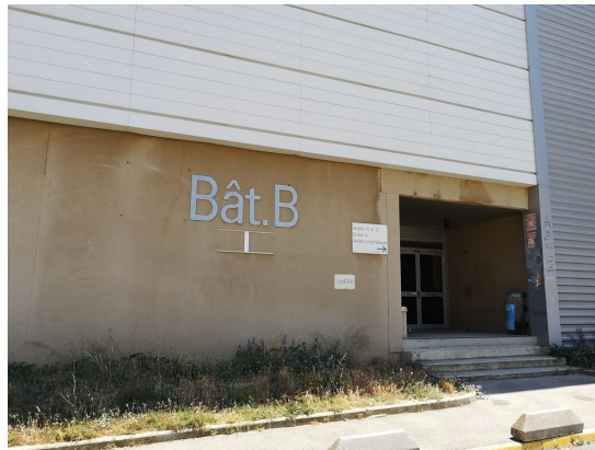
Figure 2 : Le Bâtiment B de Luminy
